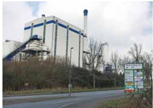
Gewerbegebiet König Ludwig 4 / 5: Das durch Ökotech betriebene Heizkraftwerk
