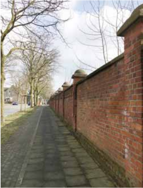
Die nahezu vollständig erhaltenen Zechenmauern entlang der Suderwichstraße
